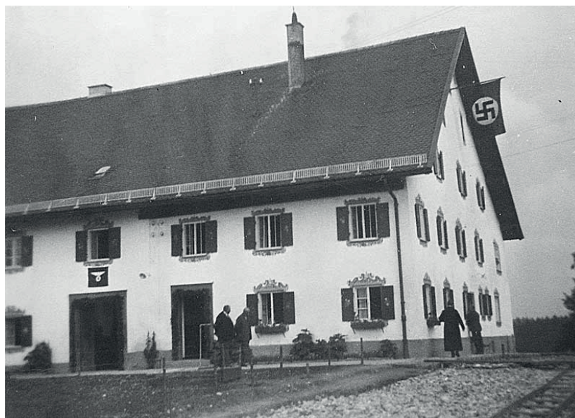
NS-Verwaltungsgebäude in Herzogsägmühle
