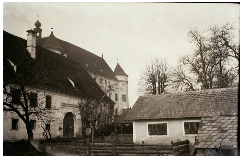
Hartheim 2, Stallgebäude rechts, mit Blick auf das Schloss
